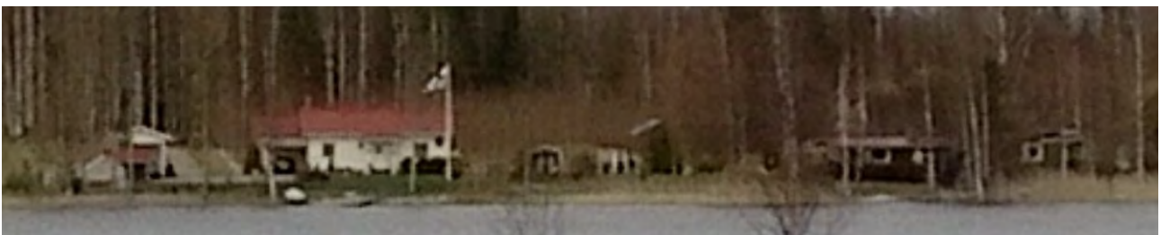
Kuva 26: Majalammen itärannan rakennuskantaa.
