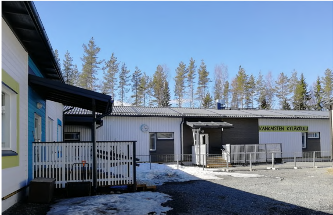
Kuva 11. Kankaisten kyläkoulun julkisivu
